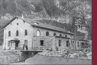
La centrale di Tel rappresentò all'epoca un'impresa di grande rilievo, sia per la potenza installata sia per la produzione di energia elettrica: i mezzi e le esperienze della tecnica in questo campo erano allora assai limitati. Inizialmente le turbine della centrale avevano una potenza di 4,5 MW; attualmente è di 28,6 MW. Col passare del tempo la domanda di energia elettrica
