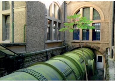
Dalla vasca di carico viene sfruttato il salto di 130 m fino al fondovalle: l'acqua precipita direttamente nelle turbine nella sottostante centrale attraverso una condotta forzata interrata.
