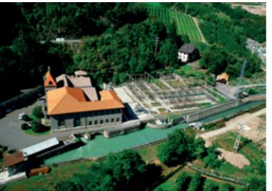
L'acqua prelevata presso la traversa di Tel viene convogliata in una galleria di derivazione a pelo libero interamente in roccia per circa 500 m per poi arrivare nella camera di carico in caverna. Da qui viene immessa in due condotte forzate che arrivano direttamente alle quattro turbine Francis poste all'interno della centrale. L'impianto sfrutta i primi 70
