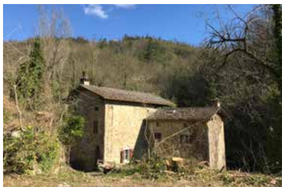
Fig. 10 - Il Molinello prima dell'intervento di ristrutturazione - ph L. Crippa
