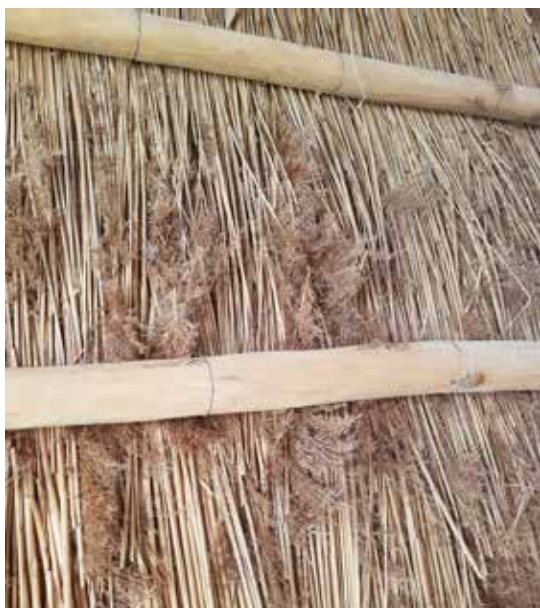
Fig. 5 - Particolare del tetto in canne - ph Daniela Taddei
