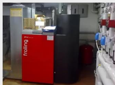
Generatore di calore a pellets a caricamento automatico
