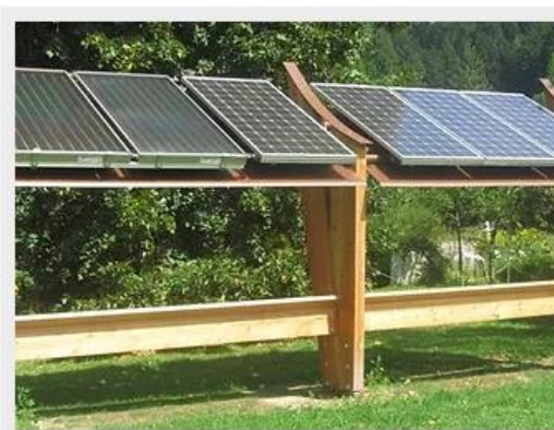
Pannelli solari termici e fotovoltaici installati su pensilina didattica
