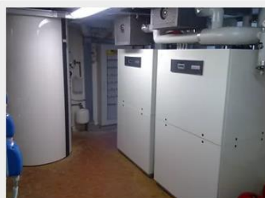
Pompe di calore geotermiche
