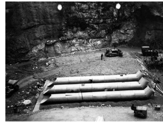
1961: posizionamento tubazioni sul letto del torrente Cismon
