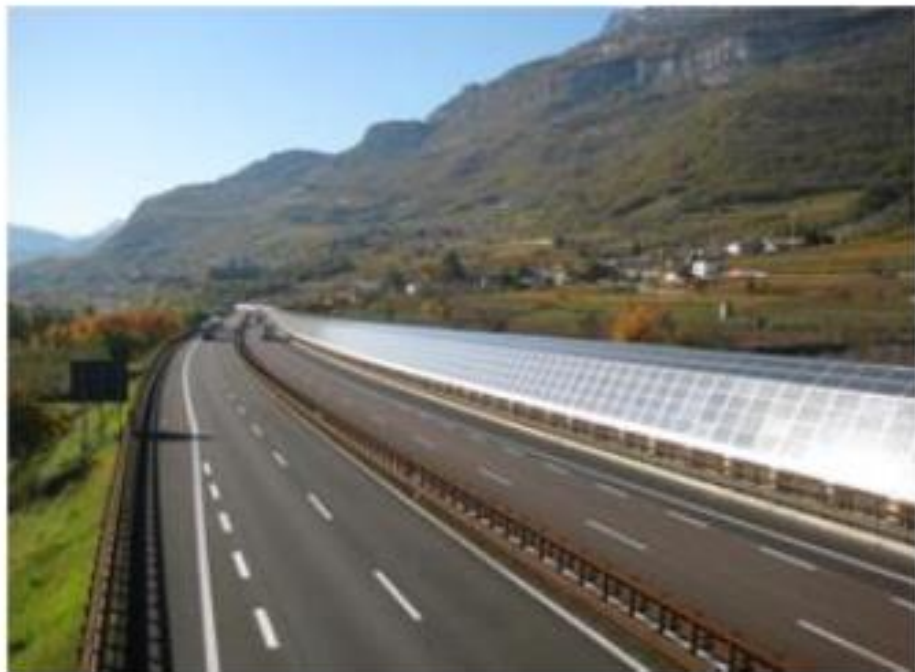
impianto su autostrada (barriera acustica)
