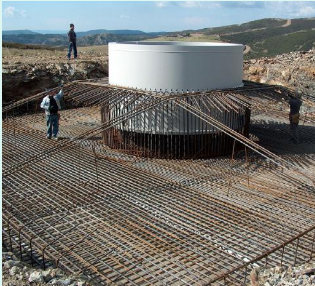
Costruzione di basamento in cemento armato per torre eolica.
