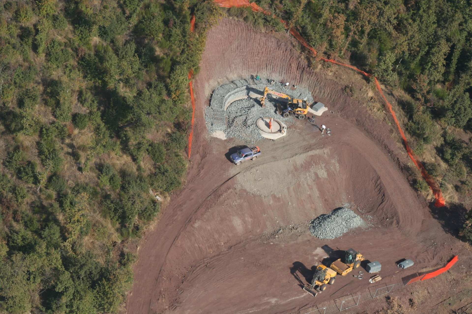
Cantiere di costruzione del basamento di una media torre eolica
