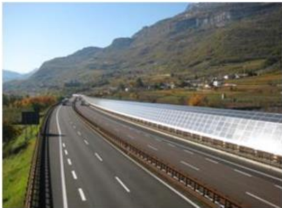
impianto su autostrada (barriera acustica)
