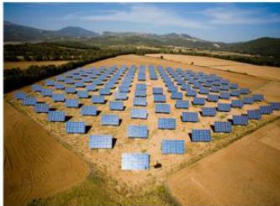
impianto a terra
