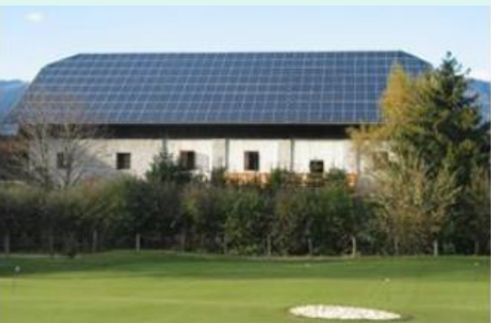
impianto su capannone
