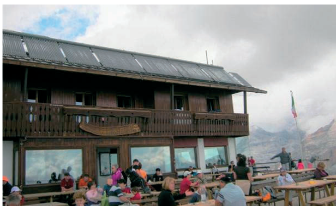
Fig. 27. Impianto solare termico con collettori piani sottovuoto a servizio del rifugio Lagazuoi, 2778 m.
