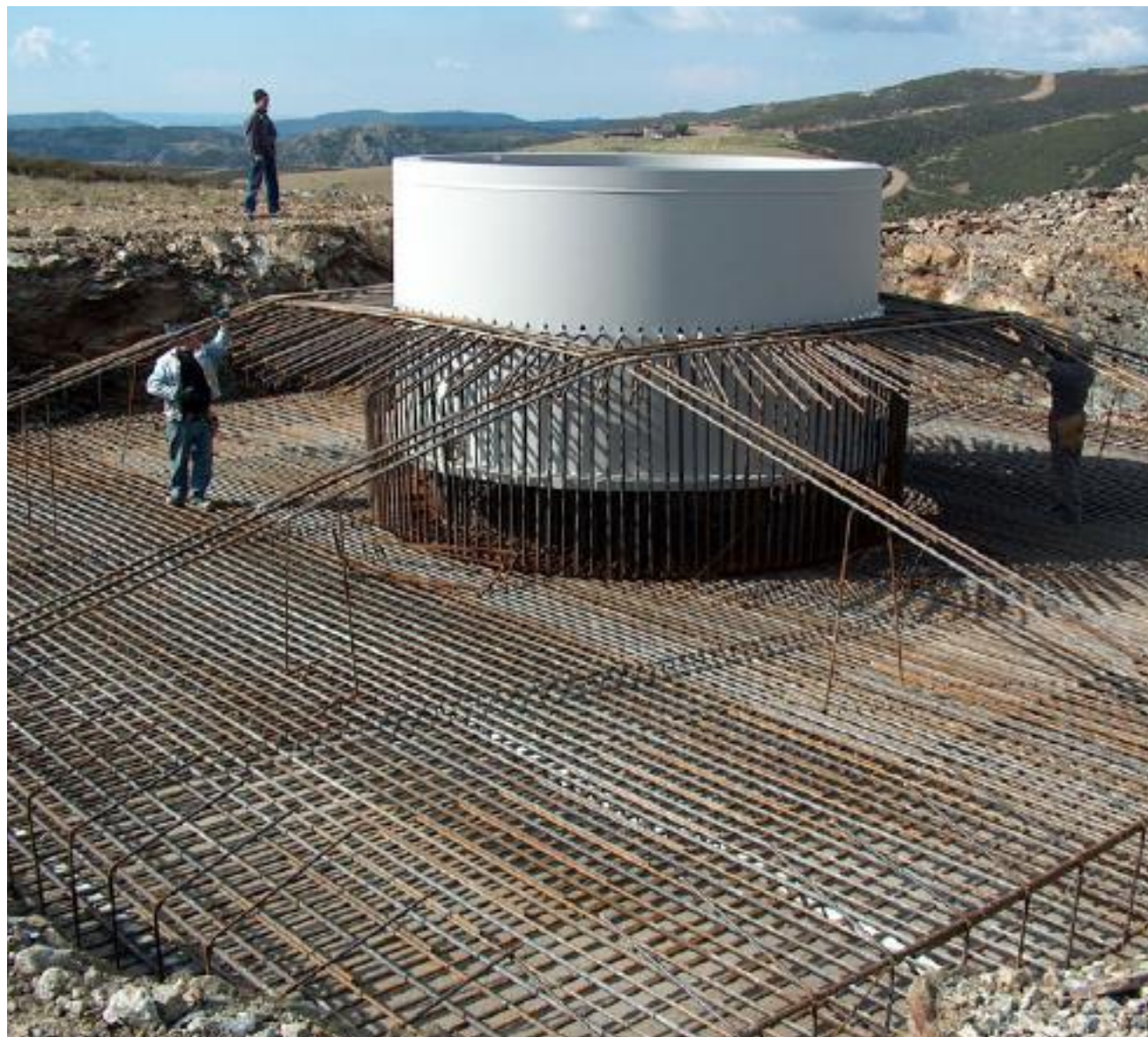
Armamento della base in calcestruzzo per torre eolica.
