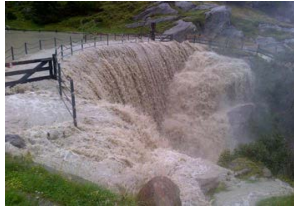
Piena Pian dell'Accla Hochwasser Aglsboden 13.08.2014
