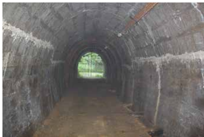
Foto 20: Interno di una galleria (foto L. Cavinato)
