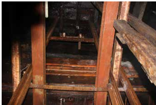
Foto 13: Pontoni di rinforzo del Pozzo Principale (foto L. Cavinato)
