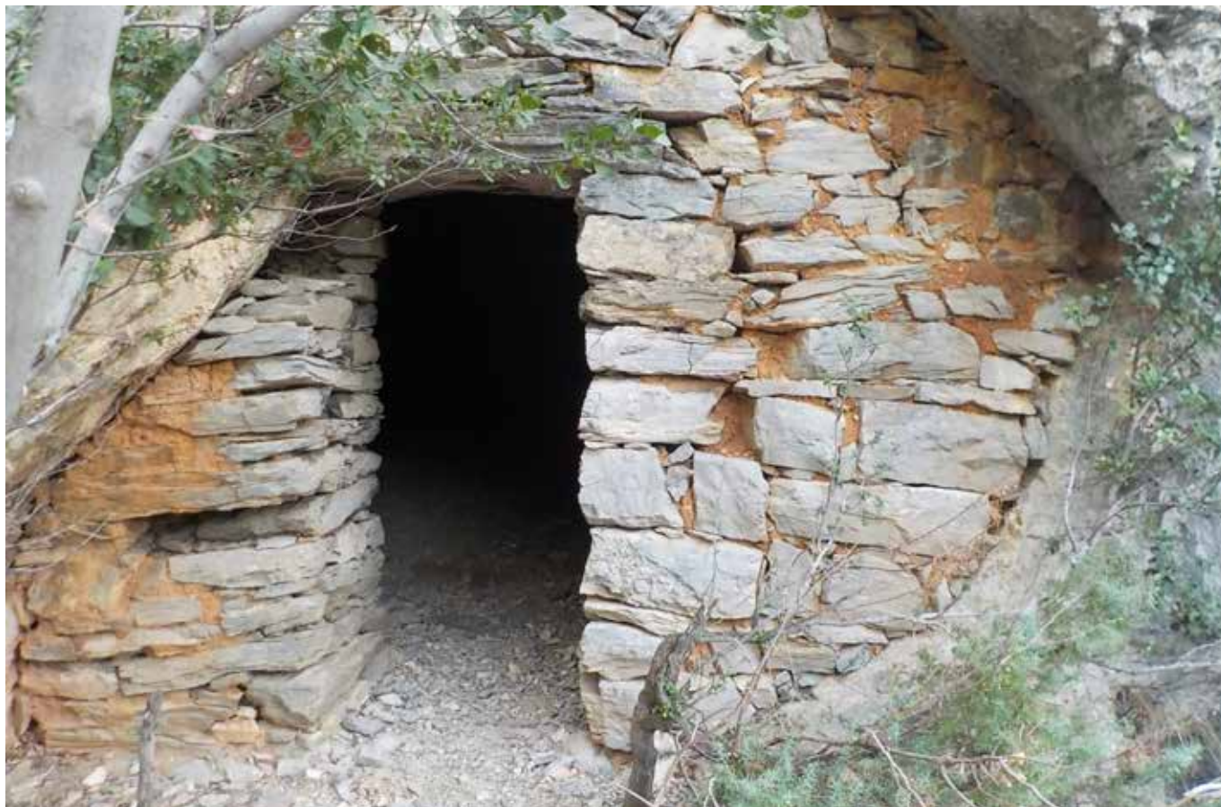
Fig. 40 - L'ingresso della Tana Sgarbà dal lato della val Varatella (foto H.D.S.)
