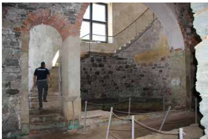
Foto 52 e 53: Interno del Museo dei Forni Fusori (foto L. Cavinato)
