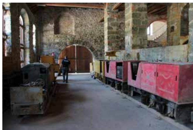
Foto 21 e 22: Interno dell'edificio dei Forni Fusori (foto L. Cavinato)
