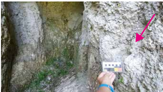
Fig. 24 - Nicchia per trave con corrispettivo nella parete opposta
