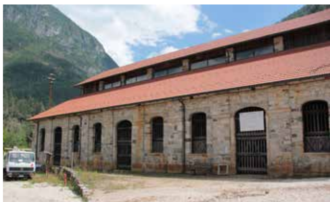
Foto 28 e 29: Edificio degli ex forni fusori (foto L. Cavinato)
