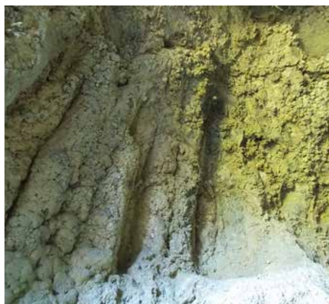
Fig. 28 - Concrezioni su scalpellature larghe - Grotta Il Ca' Castellina
