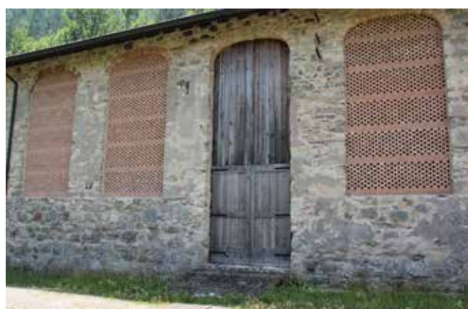
Foto 34 e 35: Edificio delle scuderie (foto L. Cavinato)
