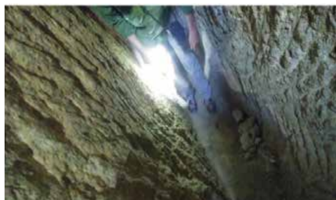
Fig. 20 - Ca' Toresina: visibile sulla parete destra scalpellature a spina di pesce a reticolo incrociato, sulla sinistra segni dall'alto al basso.
