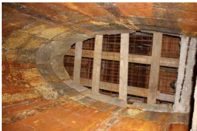
Foto 14 e 15: Accessi al Pozzo Principale (foto L. Cavinato)
