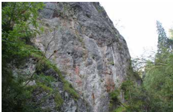
Foto 10: Versante sopra il torrente Imperina (foto L. Cavinato)
