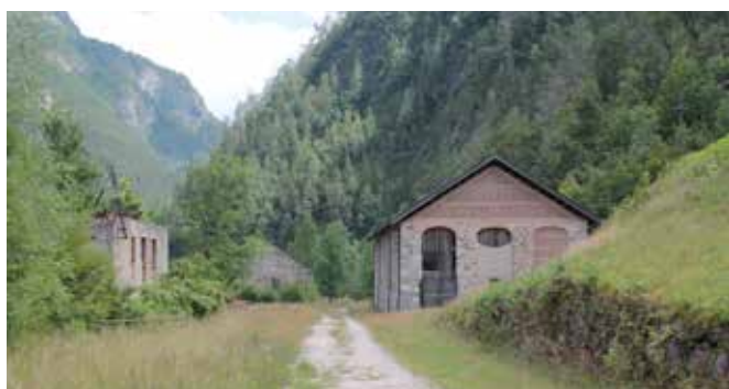
Foto 8 e 9: Alcuni edifici del sito minerario (foto L. Cavinato)
