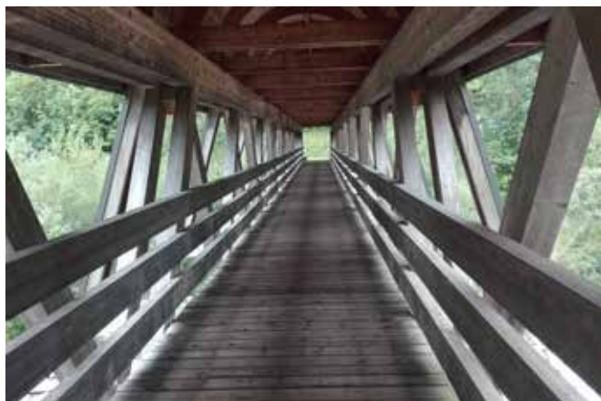
Foto 3 e 4: Il ponte pedonale di accesso al sito (foto L. Cavinato)
