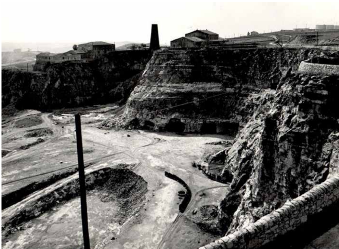
Fig. 24- Fronti scavo in cava e galleria negli anni cinquanta. Sullo sfondo la palazzina Limmer (Archivio documenti COLACEM)
