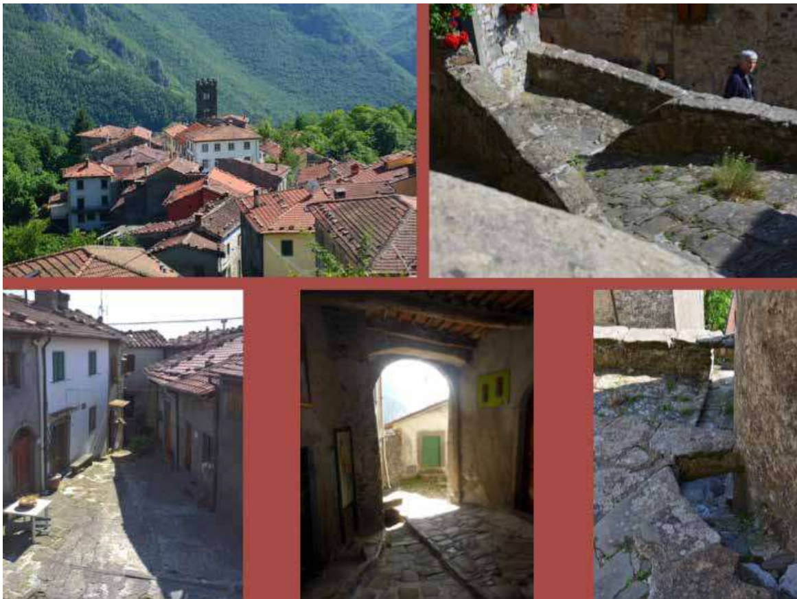
Figura 31 – Vico Pancellorum: (dall'alto a sinistra in senso orario) panorama della seconda espansione fino alla pieve di San Paolo, percorso a rampa zig zag nella prima espansione, particolare delle opere di smaltimento delle acque, porta urbana con canalizzazione delle acque a lato, piazzetta "a cuneo" del borgo castellare
