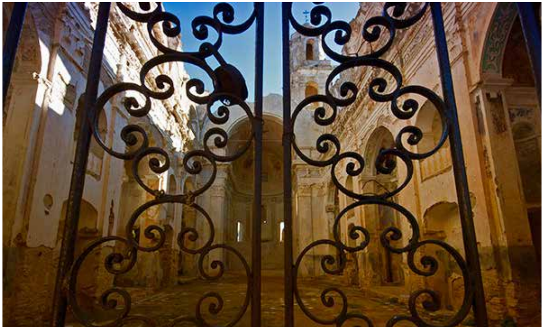
[Figura 77] - Bussana Vecchia - Resti della Chiesa di S. Egidio dopo il terremoto del 23 febbraio 1887 - ph Michele Pregliasco
