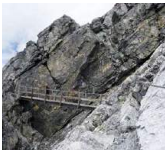
Tratto attrezzato e passerella
