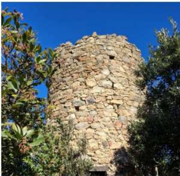
Figura 1 LA TORRE DI BAFFE
