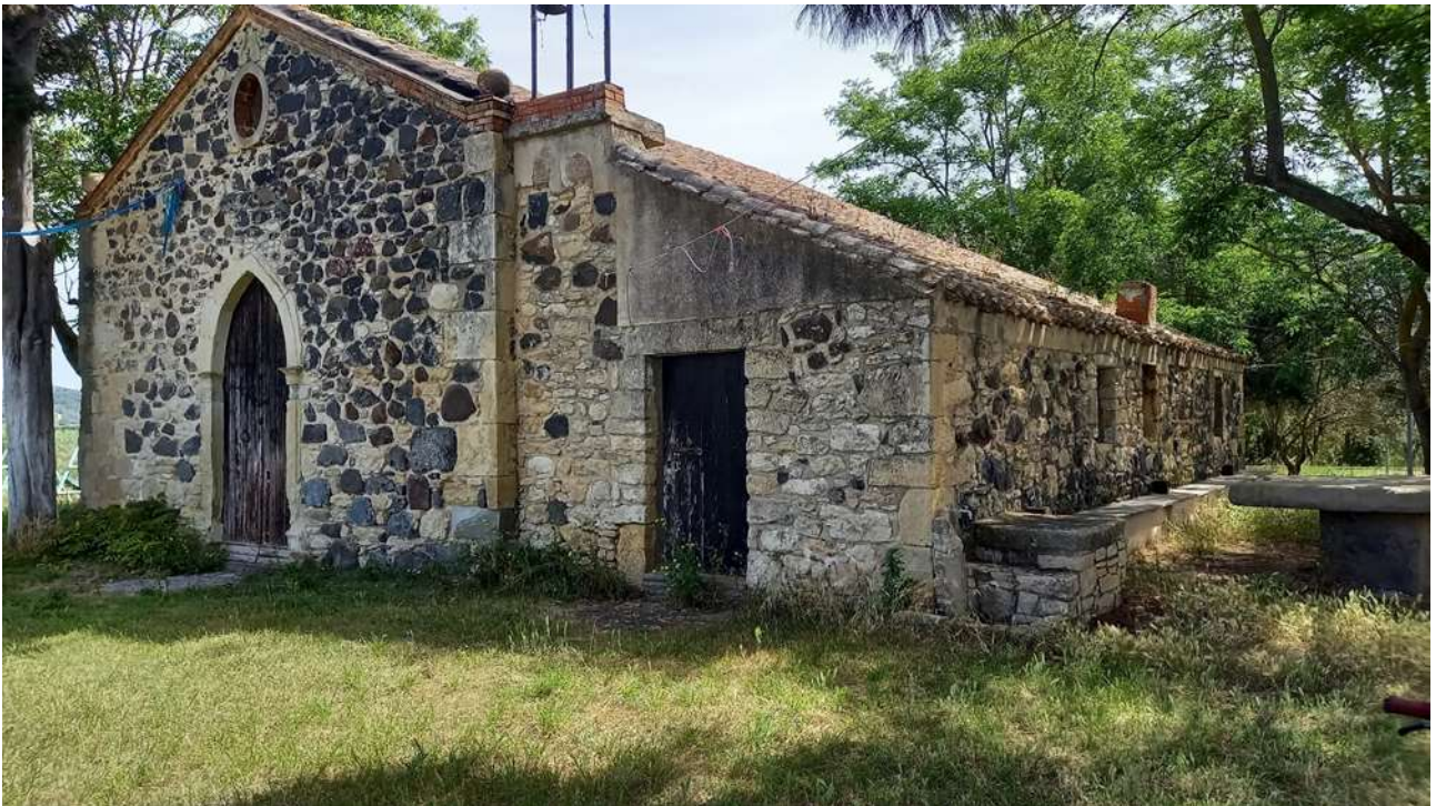
Figura 5: Chiesa di Cracaxia
