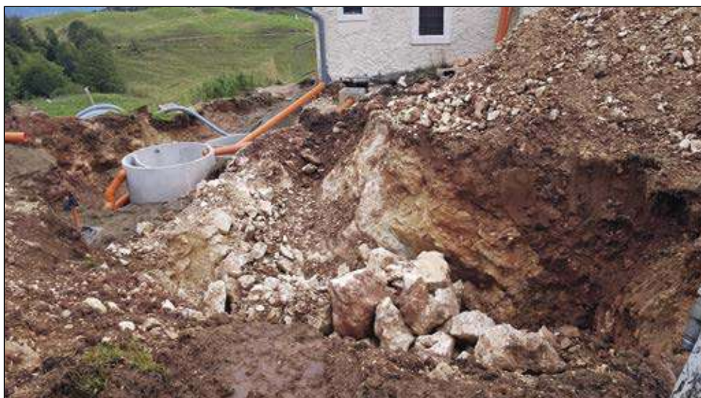
Gli scavi per installare i pozzetti di scarico
