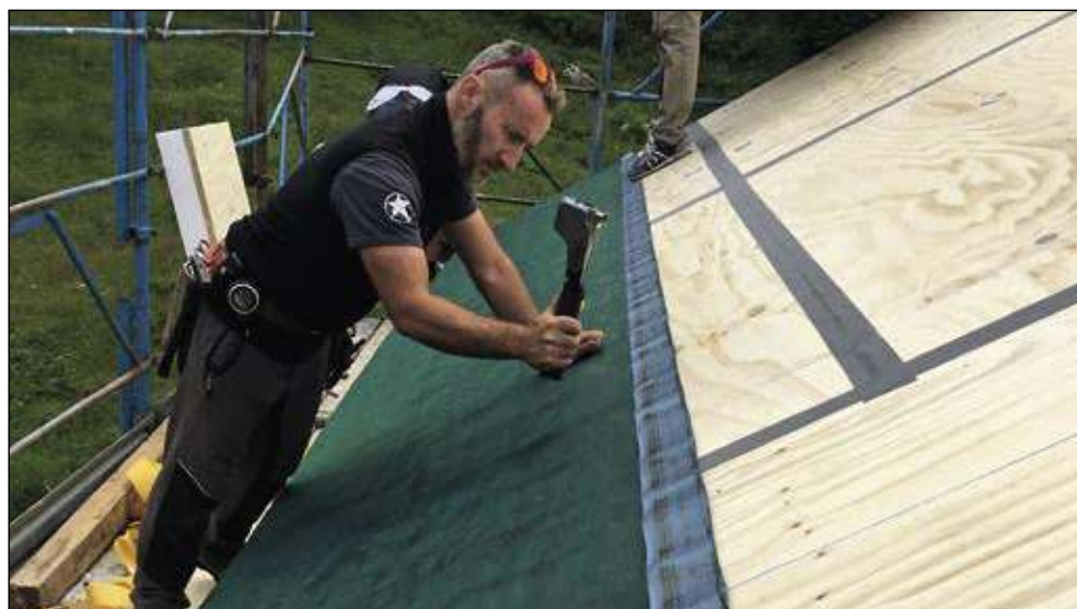
La posa della guaina sul tetto
