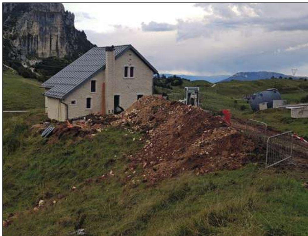
Il rifugio durante la fase di ristrutturazione
