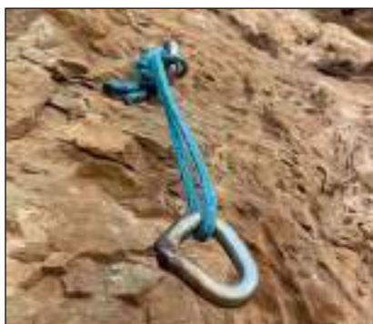
Fig.6 Fittone spezzato a causa della corrosione in ambiente marino (Sardegna)
