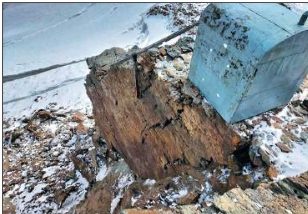
Rottura del basamento
