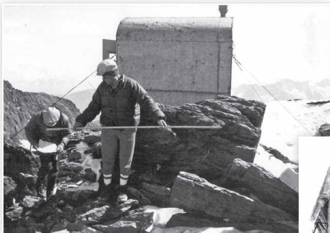
Lavori preparatori per l'ampliamento del Bivacco Meneghello
