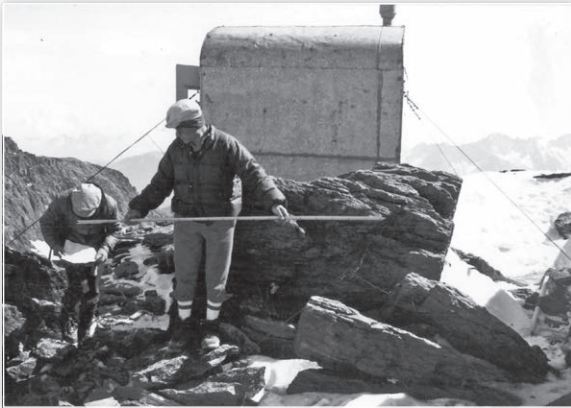
Lavori preparatori per l'ampliamento del Bivacco Meneghello
