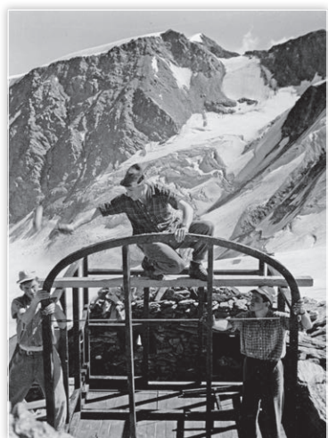
Costruzione del bivacco nel 1952
