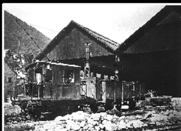
1920 - Locomotore elettrico, importato dall'America (San Francisco). Serviva per il trasporto tra la ferriera, l'acciaieria e la stazione FS.
